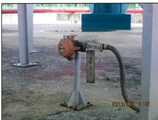
ภาพถ่ายที่ 2.2-26 อุปกรณ์ตรวจวัดก๊าซ (Gas Detector) บริเวณที่เก็บ LPG ภายในพื้นที่โครงการ
